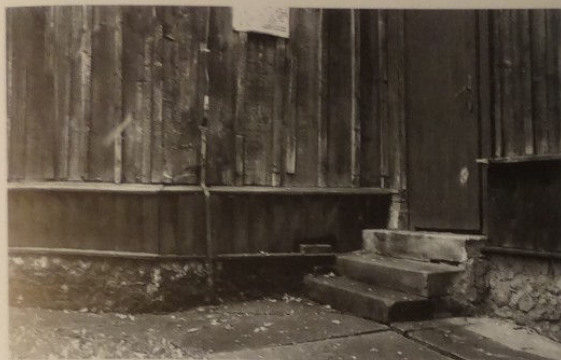
Ryc. 10. Fragment zniszczonego szalunku ścian prezbiterium i cokołu. Uszkodzone schody betonowe wiodące do zakrystii oraz przypadkowo dobrane drzwi zewnętrzne. Stan w 2010 r.
