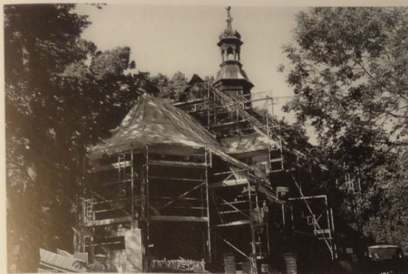
Ryc. 13. Wymiana pokrycia dachowego oraz szalunku ścian. Widok od strony prezbiterium, maj 2012 r.
