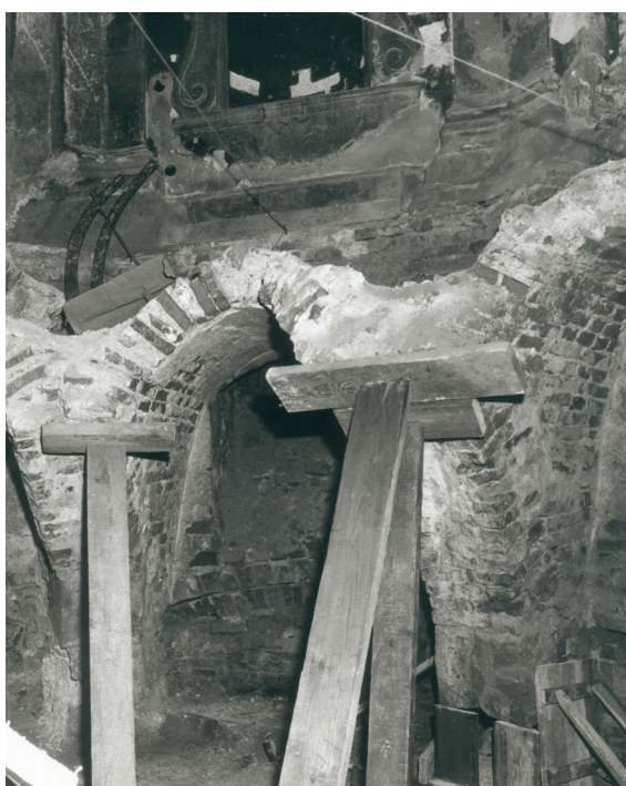
Rys. 4. Fragment zachowanych szerokich żeber sklepienych schodzących do poziomu posadzki krypty po odgruzowaniu w 1991 r. Fot. J. Doraczek, ze zbiorów Archiwum WKZ w Krakowie
